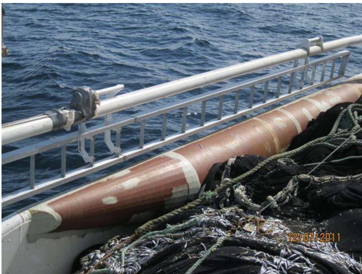
Figur 1: Permanent søgelænder langs notbinen monteret efter ulykken (Foto: Skibets reder)
